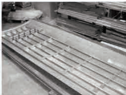
Рис. 8. Листы обшивки с приваренными стрингерами и монтажными зажимами
